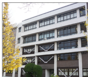
▲ 図書館耐震補強
